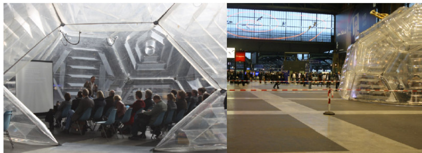
Fig.: Aufbau eines 80m 2 -Pneumocell-Domes im Hbf Zürich
